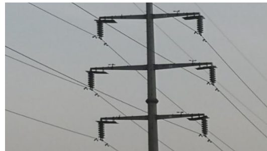
图16 无人机拍摄的电塔
